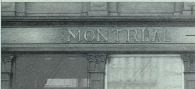
AINSI, L'ENSEIGNE À PLAT DOIT S'INSÉRER DANS UNE SURFACE PLANE DE L'ÉDIFICE, NORMALEMENT ENTRE LES LINTEAUX DU REZ-DE-CHAUSSÉE ET LES ALLÈGES DES FENÊTRES DE L'ÉTAGE.
